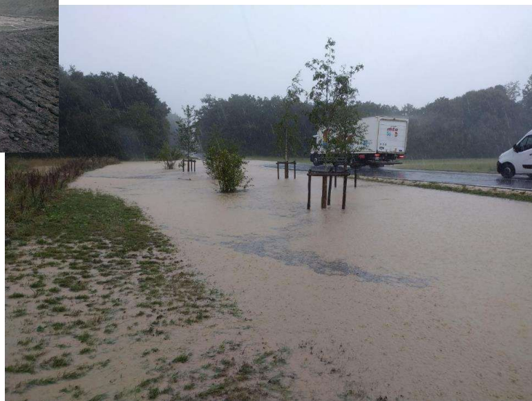
Les fossés le long de la RD 32 sont saturés dès 11h
