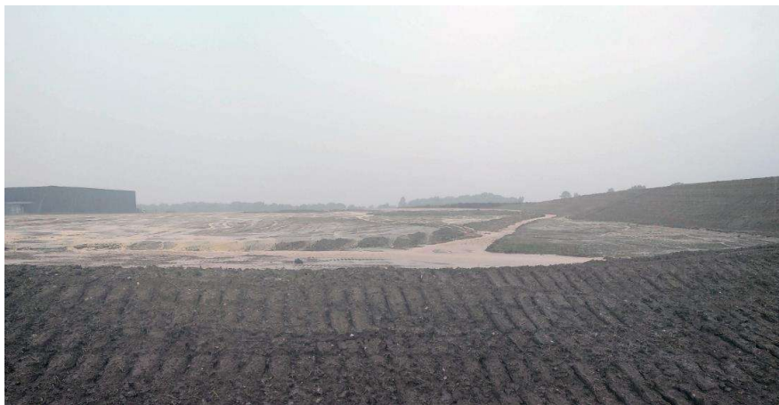
Le chantier d'extension du parking de l'Illiadé (PEX Extérieur) en cours de décapage, ruisselle abondamment vers la RD 32
