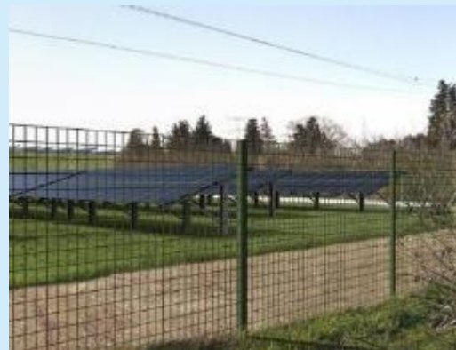
6 La clôture et les pistes
