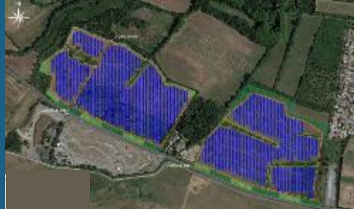
Centrale au sol sur jachère – 20 MWc
