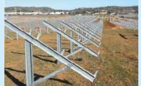
4 Les fondations (pieux)
