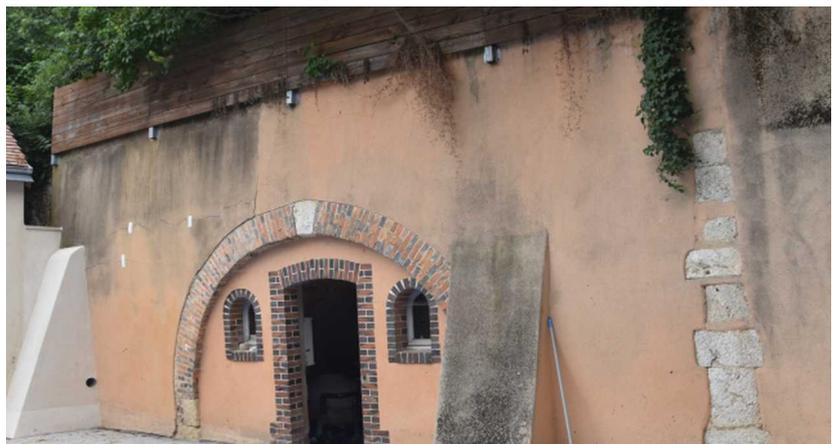
Figure III.5: exemple de mur déformé par la pression du terrain avec présence de contrefort et pose de témoins (2, Grande-Rue).
