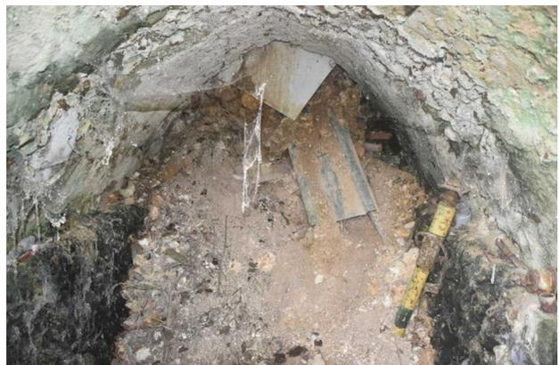
Figure III.7: effondrement de l'entrée de la cavité C45 au 50 Grande-Rue.
