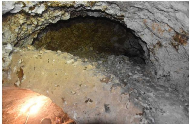
Figure III.8: zone de vide présente au dessus de la voûte de la cavité C17C du 72 Grande-Rue, avec développement d'une cloche de fontis.
